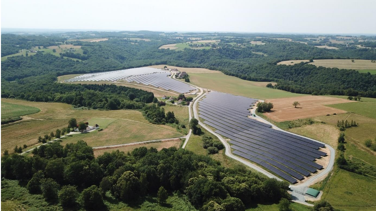
La centrale du Domaine d'Essendieras à Saint-Médard-d'Excideuil (Dordogne). 18 hectares au sol pour produire l'équivalent de la consommation électrique annuelle d'une ville de 17.000 habitants.
